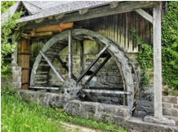
Oberschlächtiges Wasserrad im Freilichtmuseum Neuhausen ob Eck. Über dem Wasserrad ist die Zulaufrinne.
